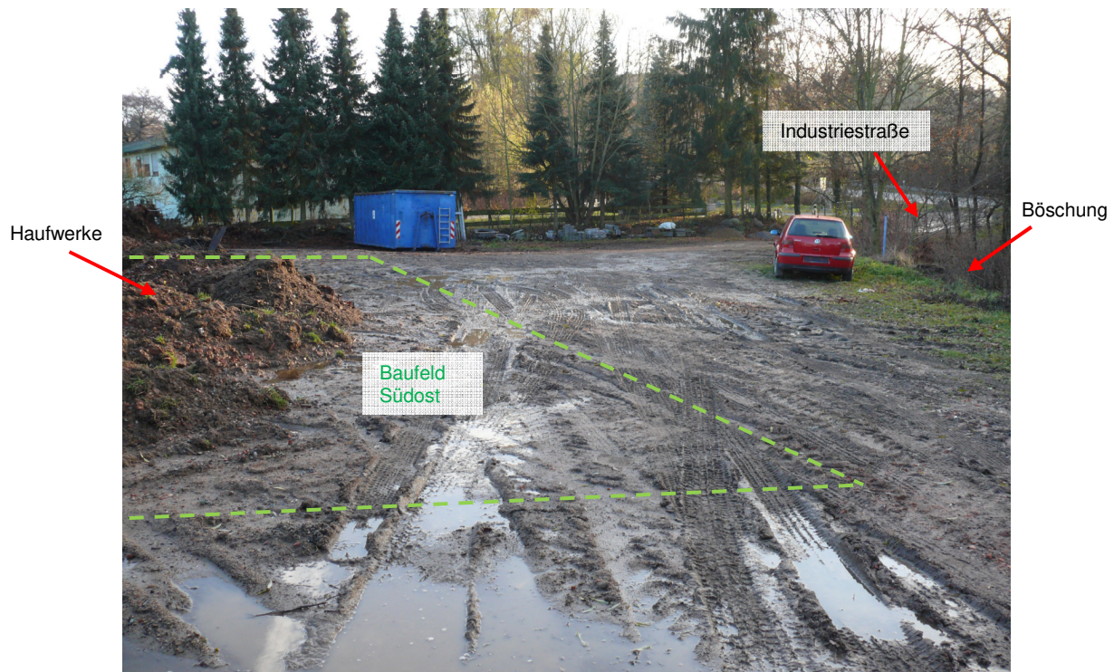
Bild 2: Baugrundstück, Bereich Süd, Blick nach Süden (05.12.2018)
