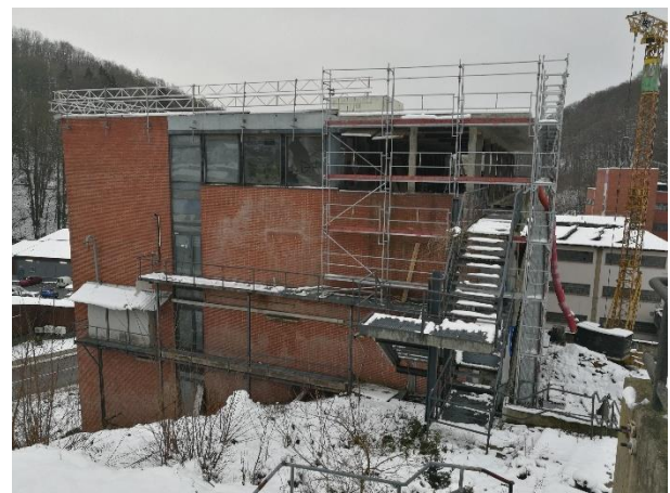
Foto 4: Ehemaliges Laborgebäude (Rückseite / Nordostfassade)
