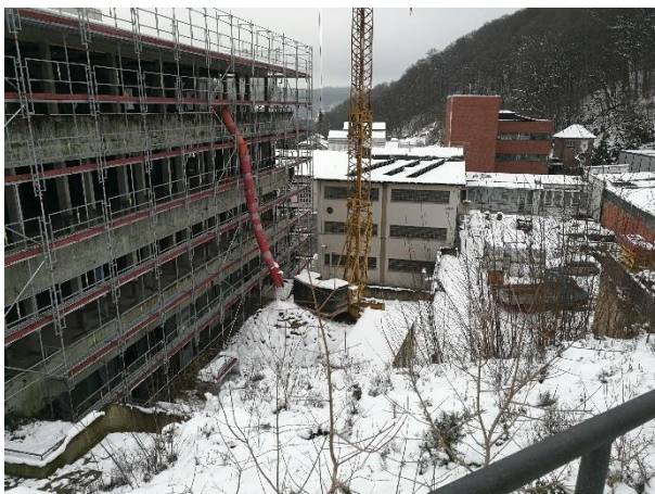
Foto 3: Ehemaliges Laborgebäude (Rückseite / Nordwestfassade)
