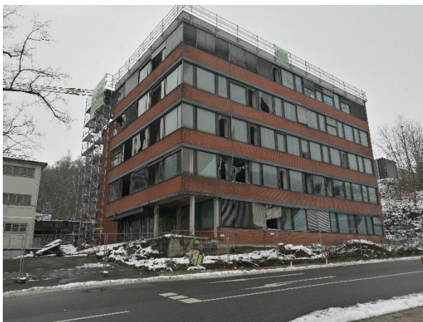
Foto 1: Ehemaliges Laborgebäude (Straßenseite „Nibelungenstraße“)
