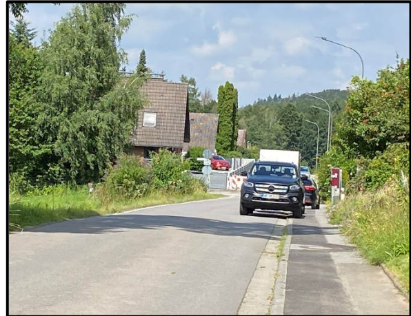
Bebauung entlang der südlichen Seite der Krehbergstraße
