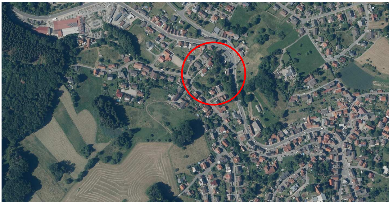
Abbildung 4: Luftbild des Plangebietes und der näheren Umgebung (unmaßstäblich) aus 2019, Bildquelle: Hessische Verwaltung für Bodenmanagement und Geoinformation, Download am 27.06.2022
