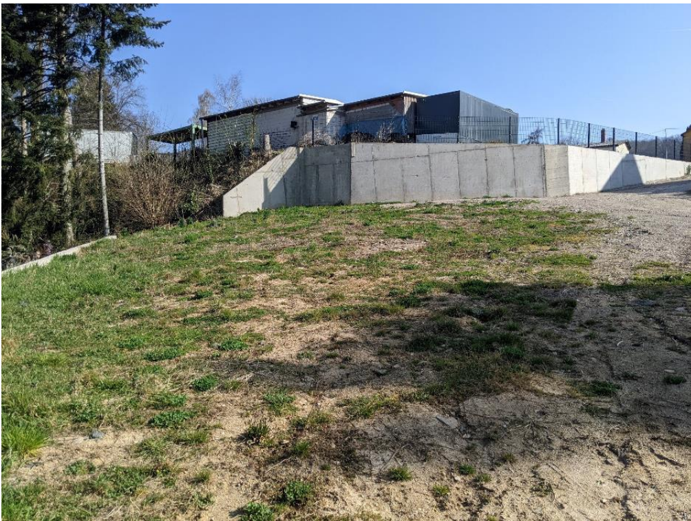
Abbildung 9 Detailansicht oberer Abschnitt
