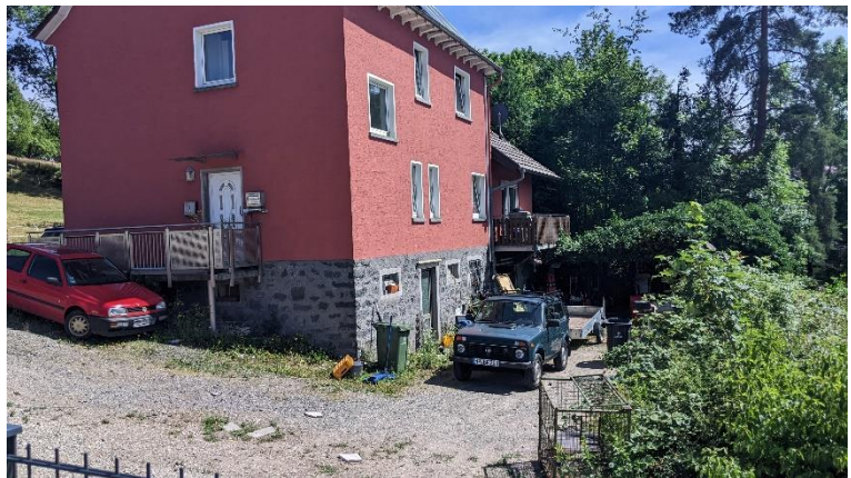
Abbildung 8: Gebäude Nibelungen- straße 683
